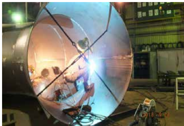
ダクト管の製作
