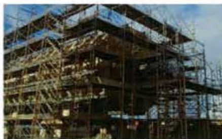
足場架設工事
