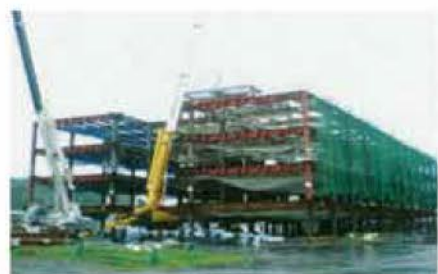
鉄骨建方工事
