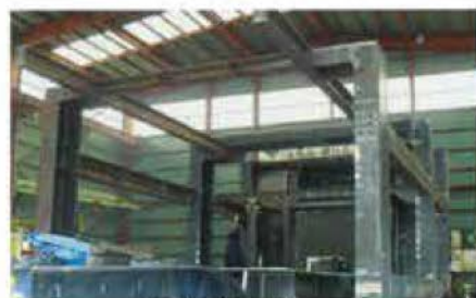
鋼構造物製作
