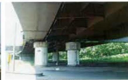
橋梁補強工事
