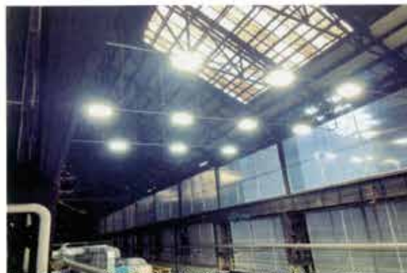
(2019年度JSW工場LED化工事)
