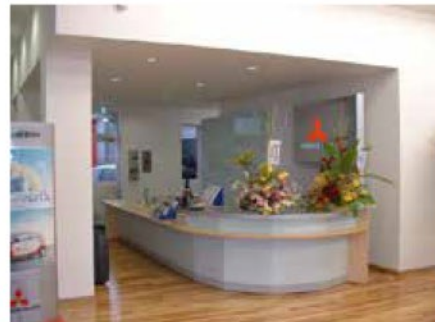
M自動車改修工事
