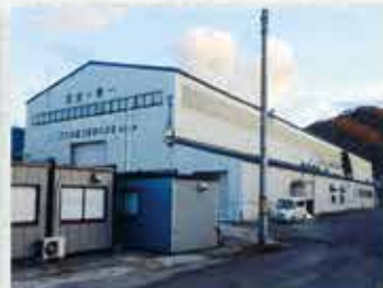
▲ 塗装工場棟 (2,138m) 外観
