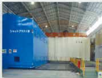
▲ 塗装工場棟 (2,138m) ショットプラスト室・塗装室
