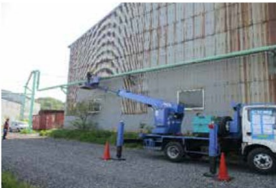
日鋼構内（全域）：LNG配管点検・塗装工事
